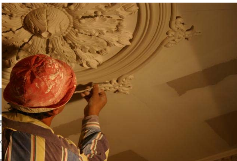
Estuques e Gessos Decorativos Trabalho de Remate de Estuque num Tecto de Habitação Casa Particular Campo Ourique (Lisboa)
