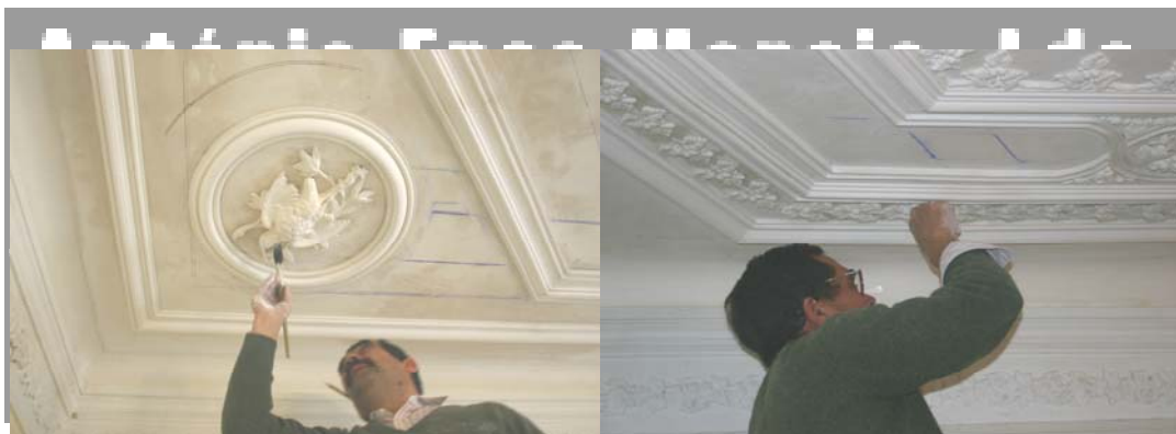
Sequência de Restauro de um tecto estuque trabalhado numa residência particular à Rua de São Bento
