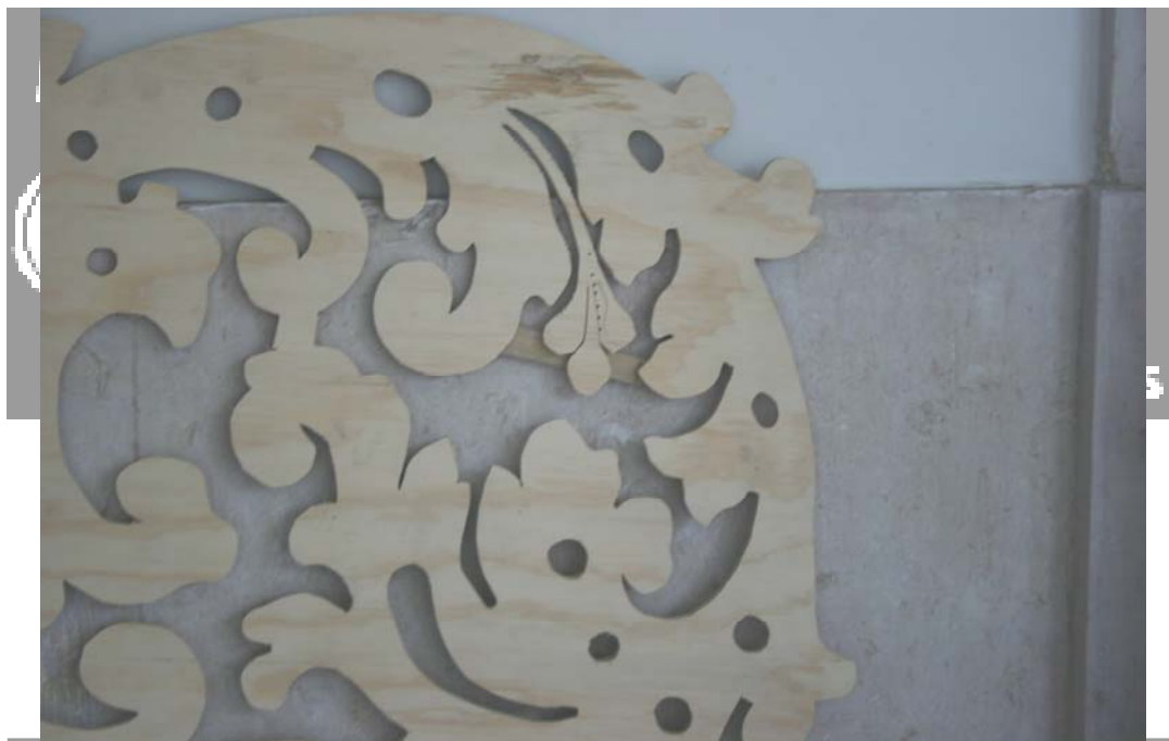
António Enes Morais, Lda Detalhe do Molde para Estuque Grafitado Restauro Palacete Príncipe Real em Lisboa
